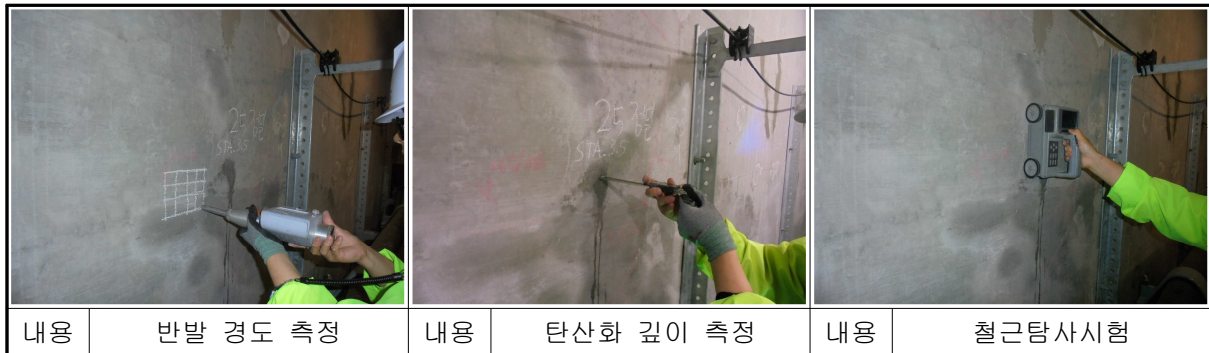
【사진 3.4】 문발SS인출 전력구 재료시험 전경
